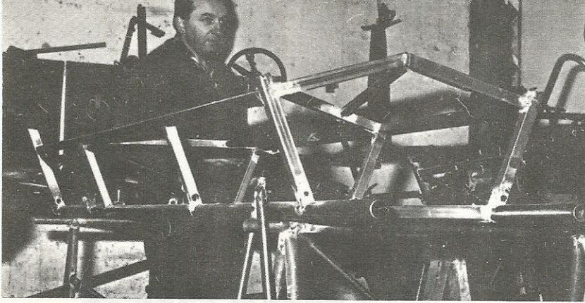
Châssis de la « Monoplace », simplifié au maximum pour la fabrication en série (au fond, M. Marcadier).
